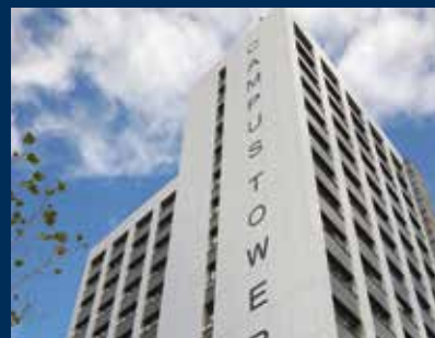
Hostel Campus Tower Magdeburg, Německo
