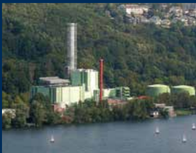
Plynová elektrárna, Herdecke, Německo
