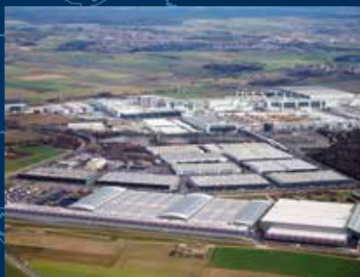
Freight Village Ingolstadt, Německo
