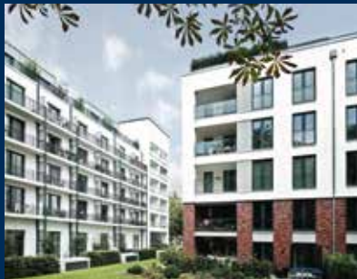
Bytový dům, Hamburk, Německo
